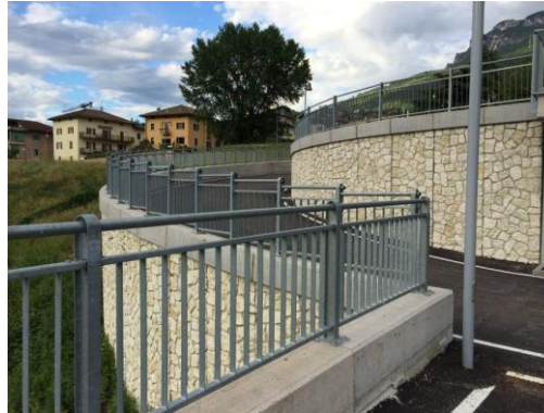
Figura 2 – muro in curva senza fuga mascherata
