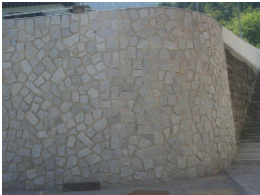
Figura 3 – realizzazione curva con raggio ridotto
