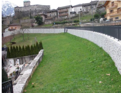
Figura 4 – muro in curva con fuga mascherata
